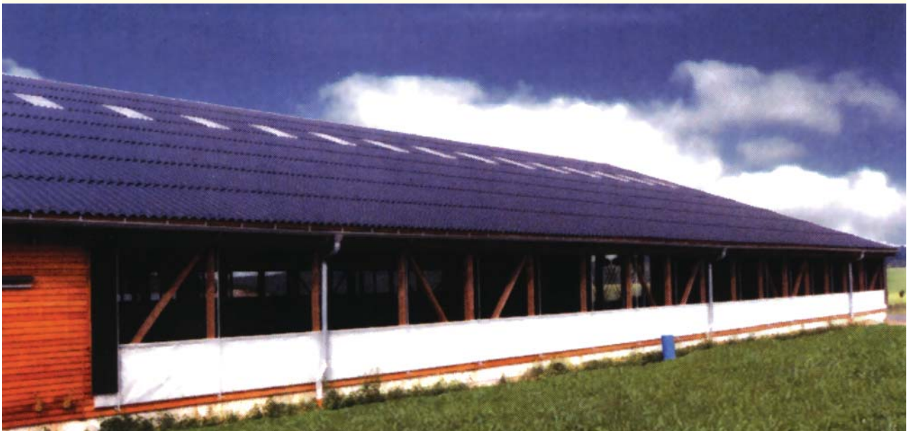
Рисунок 1.2 – Вигляд ззовні на бокові штори легкозбірного приміщення.
