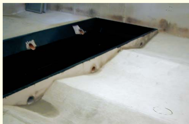
Рисунок 2.12 – Гнойовий канал
